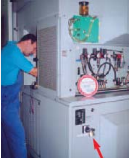
图 11：加锁的总开关，并附带标识。（参考[25]）
